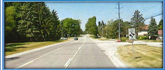
Westbound Tienken Rd
