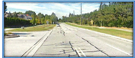
Westbound Tienken Rd
